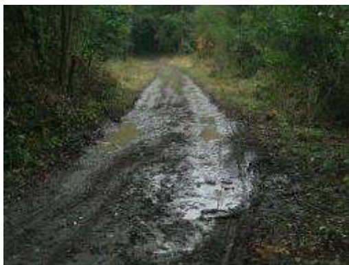
Obr. č.1: Původní stav lesní cesty
