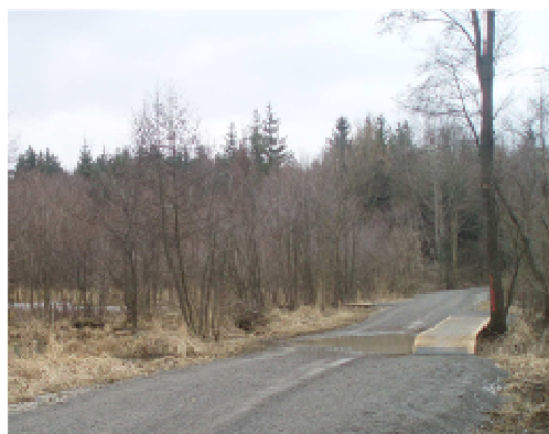
Obr. č.2: Realizovaný demonstrační objekt
