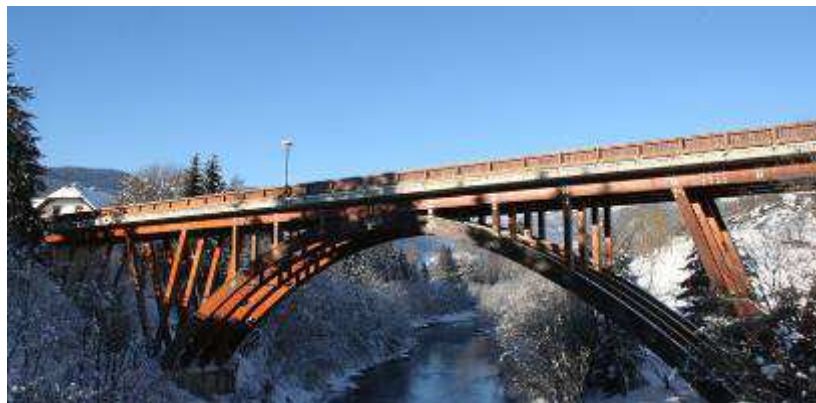
Obr. č.1: Dálniční most v Rakousku
